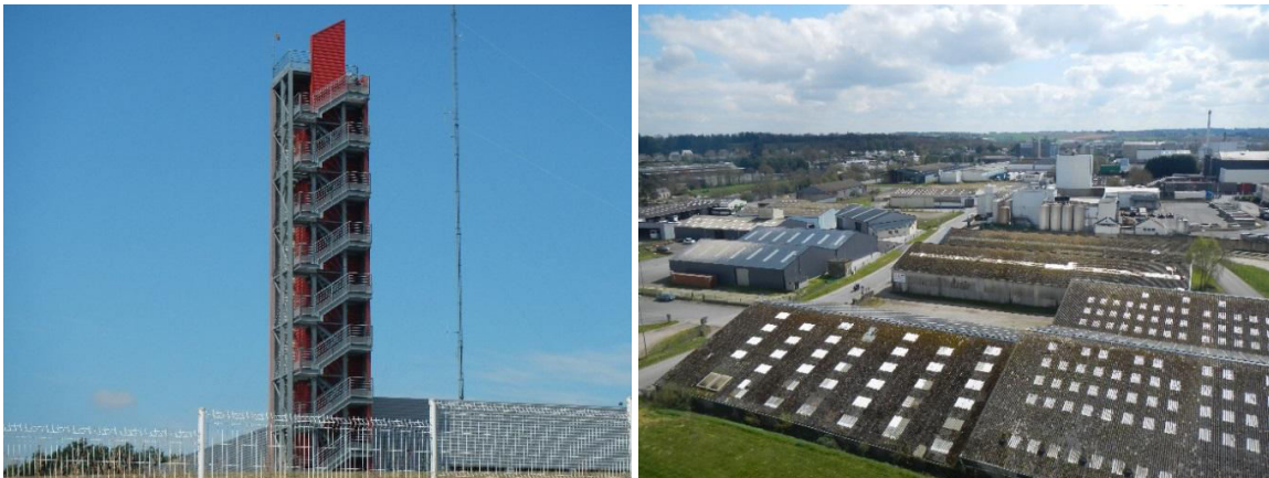
Figure 1 : Tour du centre de secours (Pontivy) et aperçu de la vue depuis son sommet – Photos TBM environnement
