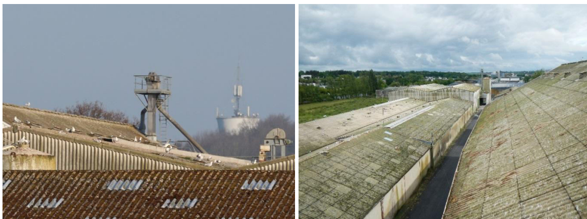
Figure 2 : Tour élévateur de l'entreprise SPCP (Pontivy) et aperçu de la vue depuis son sommet – Photos TBM environnement
