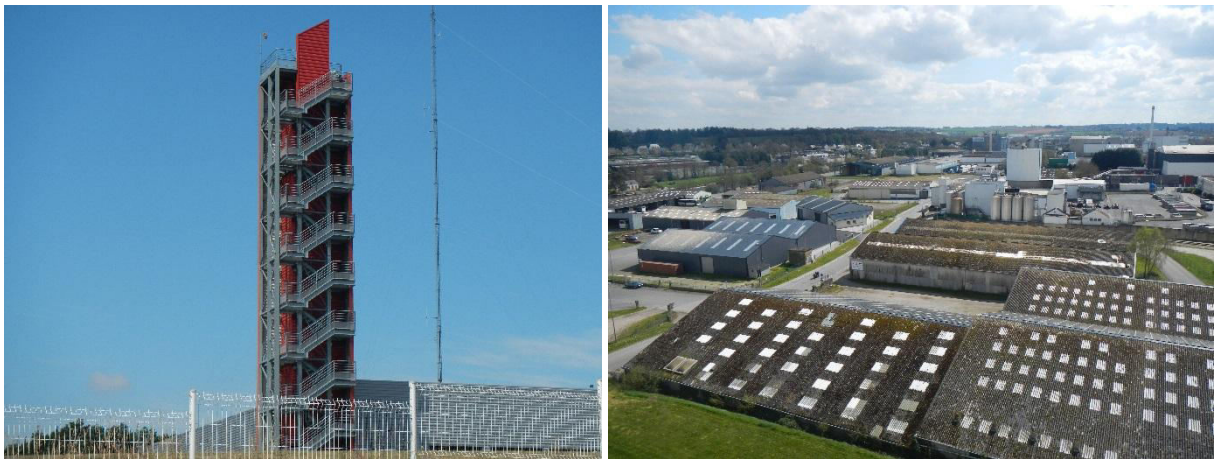
Figure 4 : Tour du centre de secours (Pontivy) et aperçu de la vue depuis son sommet – Photos TBM environnement
