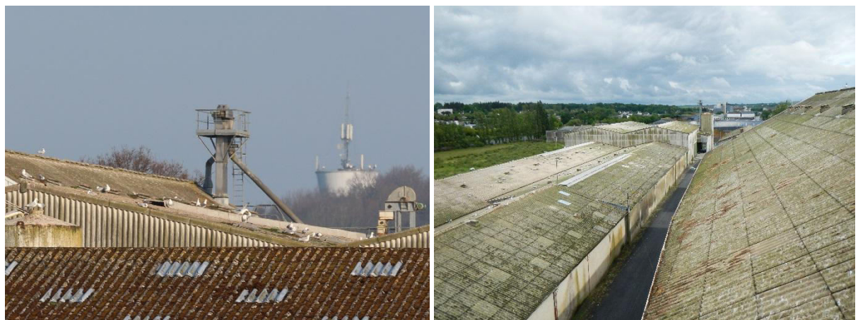
Figure 5 : Tour élévateur de l'entreprise SPCP (Pontivy) et aperçu de la vue depuis son sommet – Photos TBM environnement
