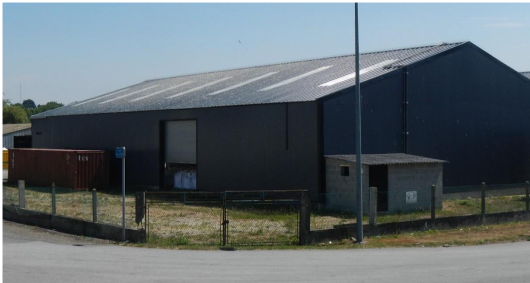
Figure 12 : Bâtiment avec toit en fibrociment rue Denis Papin (Le Sourn) occupé par quatre nids en 2016 (en haut) - Image Google StreetView - et après installation d'un toit en bac acier en 2017 (en bas) – Photo TBM environnement
